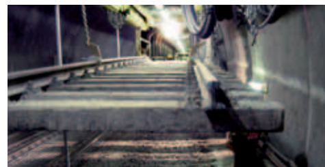
Подъём полотна пути
