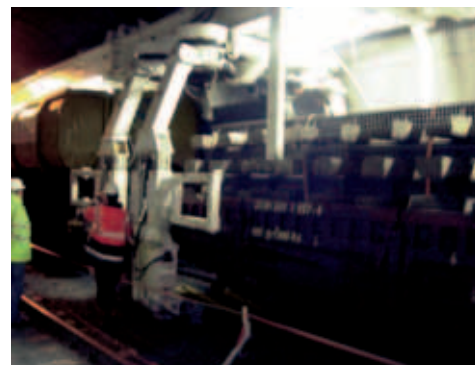
Опорная тележка III развёрнута для прохождения вагона-платформы
