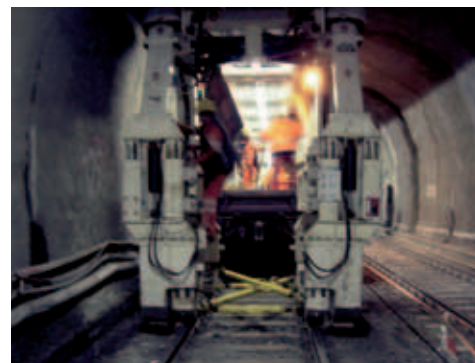
Опорная тележка III в закрытом положении
