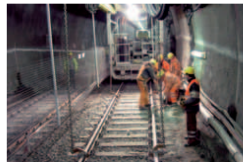
Отсоединение пути и закрепление крановой установки
