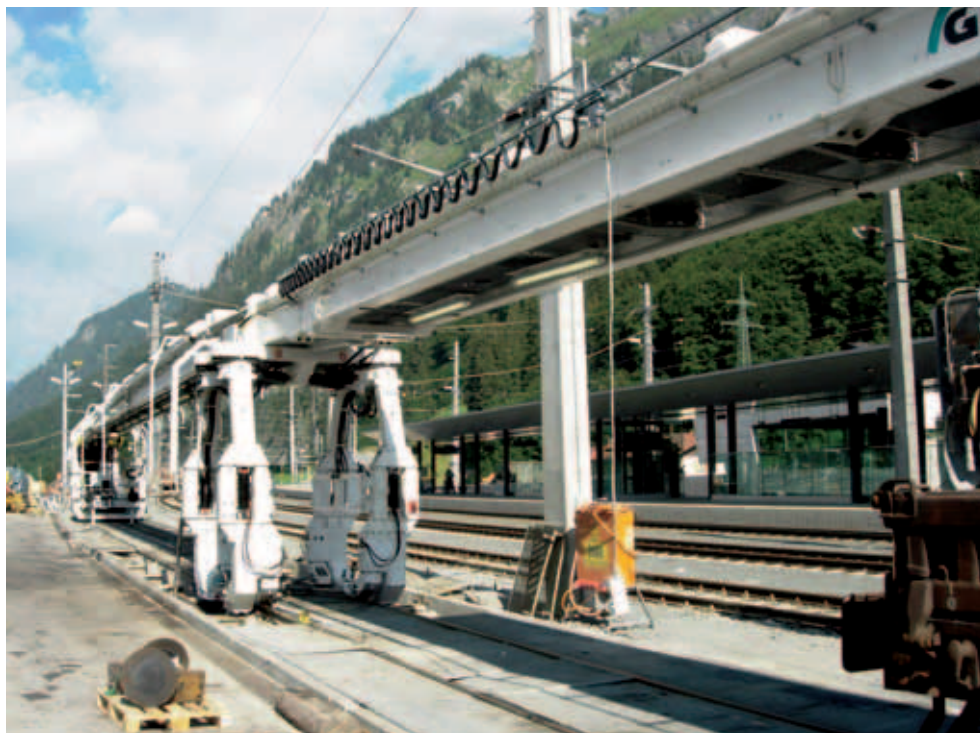
Въезд в Арльбергский тоннель
